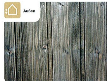
Dunkle, vergraute und verwitterte Hölzer bilden die Ausgangssituation
