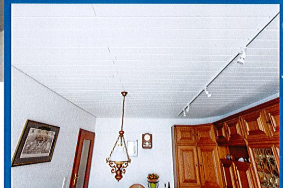
Vor der Renovierung und nachher: Mit vertretbarem Aufwand lassen sich Holzdecken neu beschichten – im Streich-, Roll- oder Spritzverfahren
