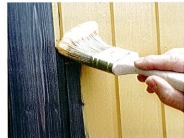
1 bis 2 mal GORI 99 im Farbton 3166 Hellocker als Spezialgrundierung aufbringen – überstreichbar nach ca. 6 Stunden
