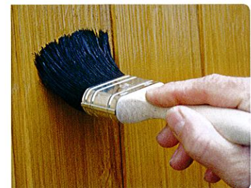
Die Zwischen- und Schlussbeschichtung erfolgt mit GORI 88 Compact-Lasur im gewünschten Farbton. Für Renovierungen in Innenräumen kann die Aufhelltechnik mit alternativen Innenprodukten aus dem GORI Sortiment natürlich ebenfalls angewendet werden
