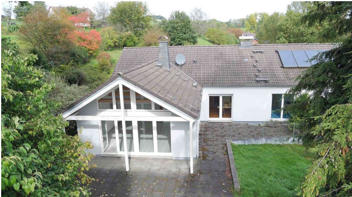
Rück-/Südseite mit Terrasse und Solaranlage
