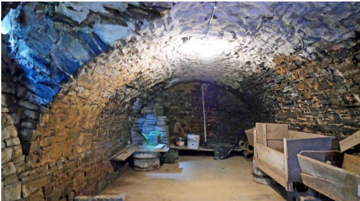
Bruchstein-Gewölbe als Wein-/ Kartoffelkeller
