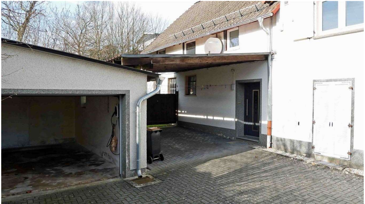
Einliegerwohnung: 60 m 2 mit eigener Garage, Carport und...
